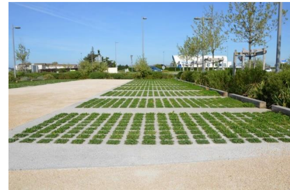
L'emploi d'un revêtement plus perméable pour le stationnement
