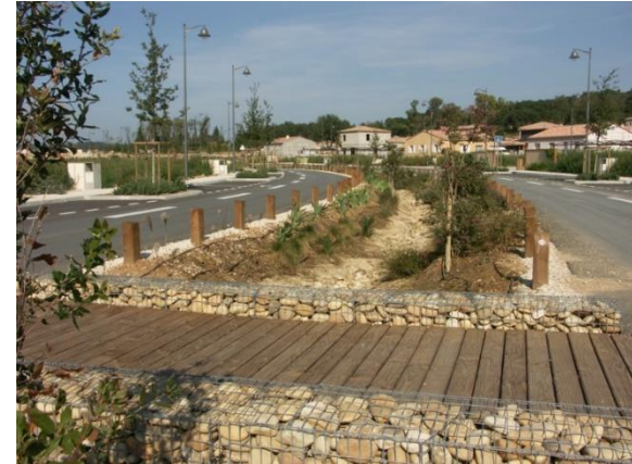
Une noue végétalisée pour une meilleure gestion des eaux de pluie
