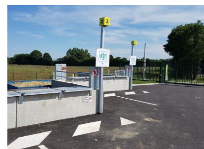
Mise en place d'une nouvelle signalétique + dispositif antichute
