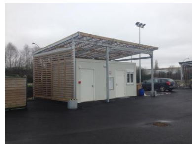
Remplacement du local gardien
