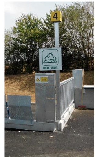
Mise en place d'une nouvelle signalétique
